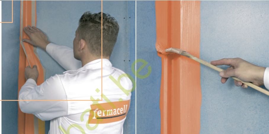
Figure 2 : Presser la bande d'étanchéité FERMACELL dans le lit d'étanchéité encore liquide et, en un 2 ème passage, la recouvrir d'étanchéité liquide
